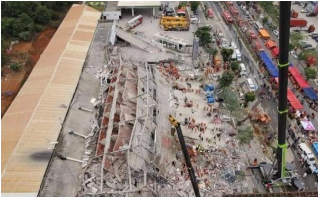
완전히 붕괴된 신자호텔(사진: scmp.com 캡처)
